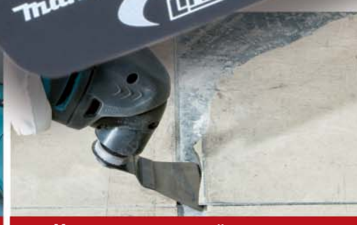
Удаление напольной плитки
