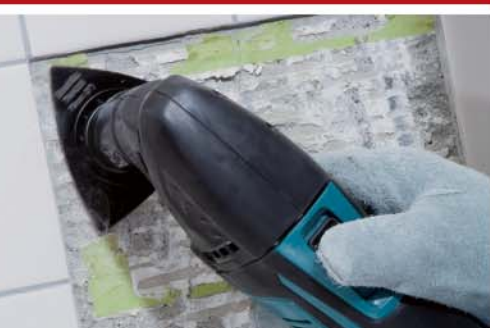
Удаление плиточного клея
