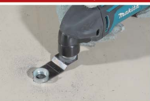
Резка металлических труб заподлицо
