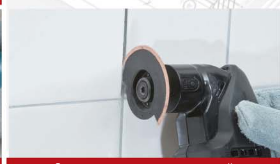
Очистка швов между плиткой
