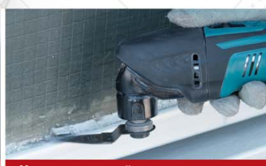
Удаление оконной замазки, герметика
