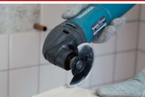
Резка керамической плитки
