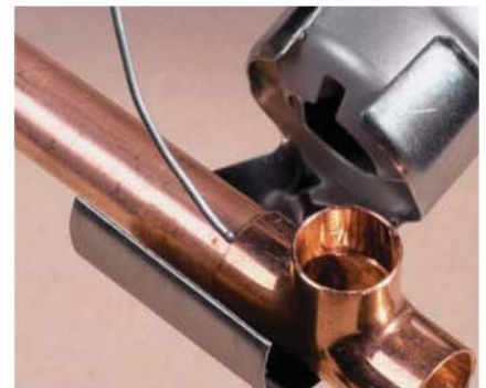
Пайка медных труб (только HG651C, HG551V)
