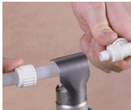
Монтаж пластиковых труб
